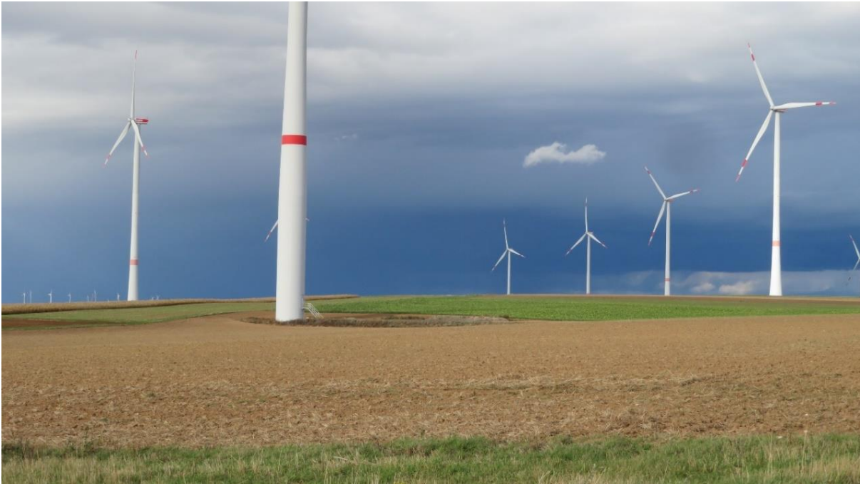
Bild 41: Windkraftwerke bei Biedesheim/Pfalz
