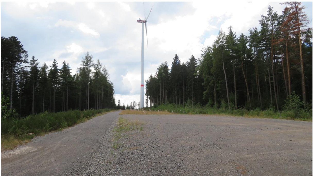
Bild 7: Dauerhaft gerodeter Wald für die Arbeitsfläche eines Windkraftwerkes auf dem Stillfüssel
