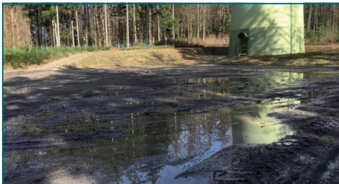
Stark verdichtete Böden am Greiner Eck; das Regenwasser steht in Pfützen. (Foto: Roswitha Kraft)
