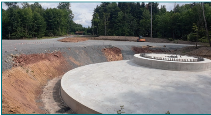
Fundament einer Windkraftanlage in Hainstadt (Foto: Henning Geierhaas)
