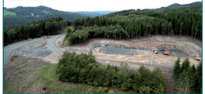
Windpark Mannstein (Foto: Rudolph Ersepke): Geländeneivellierung für eine Windkraftanlage von 3,45 MW. In unserem Wald sollen größere Anlagen gebaut werden!
